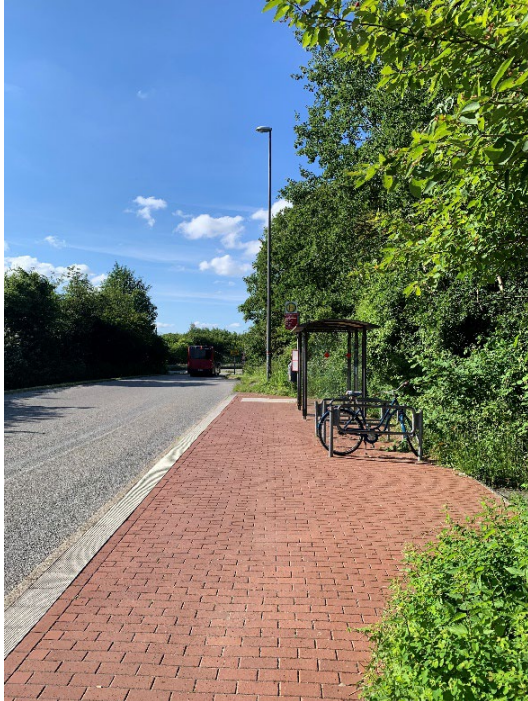
Abbildung 51 Bushaltestelle Immelmannstraße, Blickrichtung Nordwesten. 8
