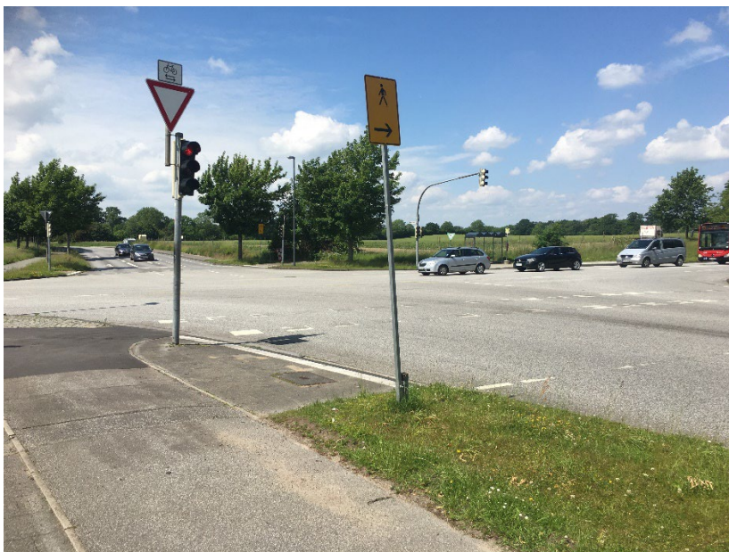
Abbildung 55 Knoten Fördestraße/Friedrichsorter Straße, Blickrichtung Norden. 11
